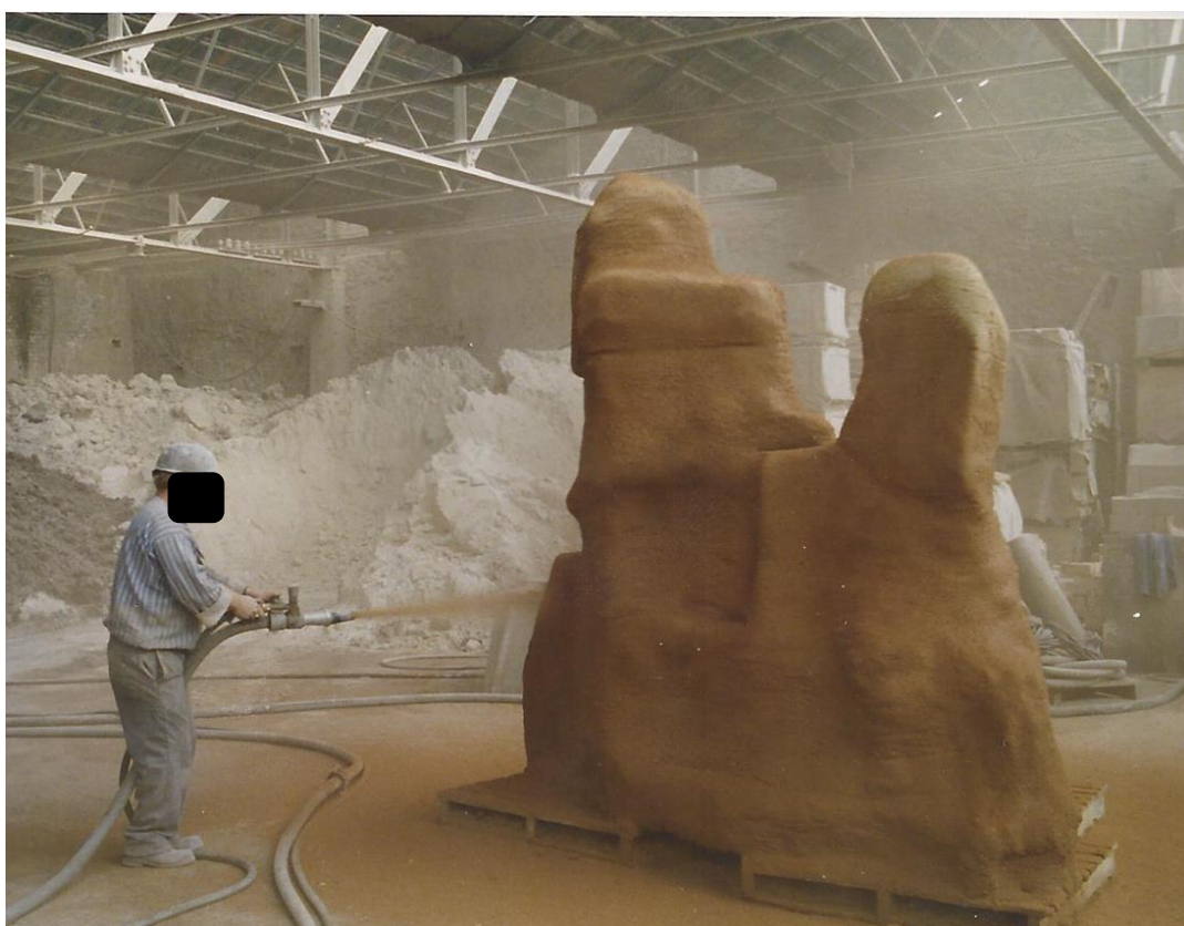
Fig. 43. Gunitage d'un décor pour parc d'attraction.
