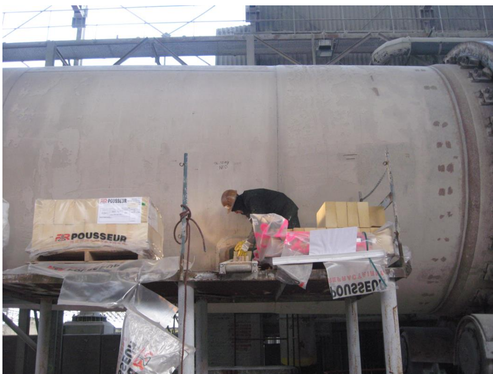
Fig. 30. Acheminement des briques réfractaires dans un four de cimenterie.
