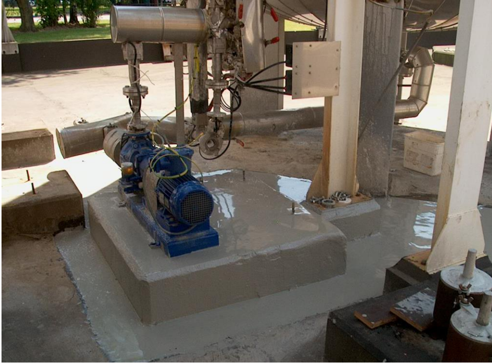
Fig. 39. Revêtement anti-acide d'un socle de pompe.
