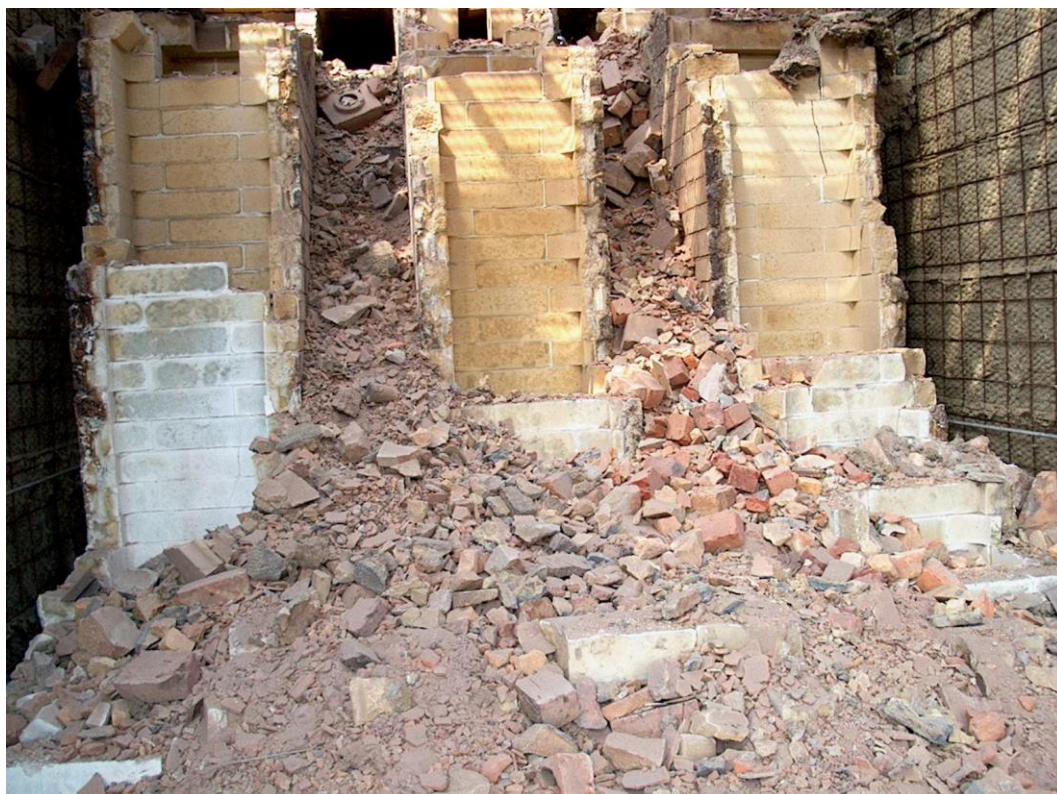
Fig. 8. Démolition de carneaux.
