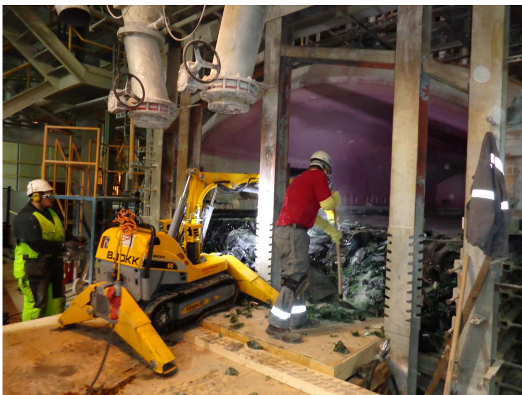
Fig. 19. Démolition de la couche de verre et évacuation manuelle.
