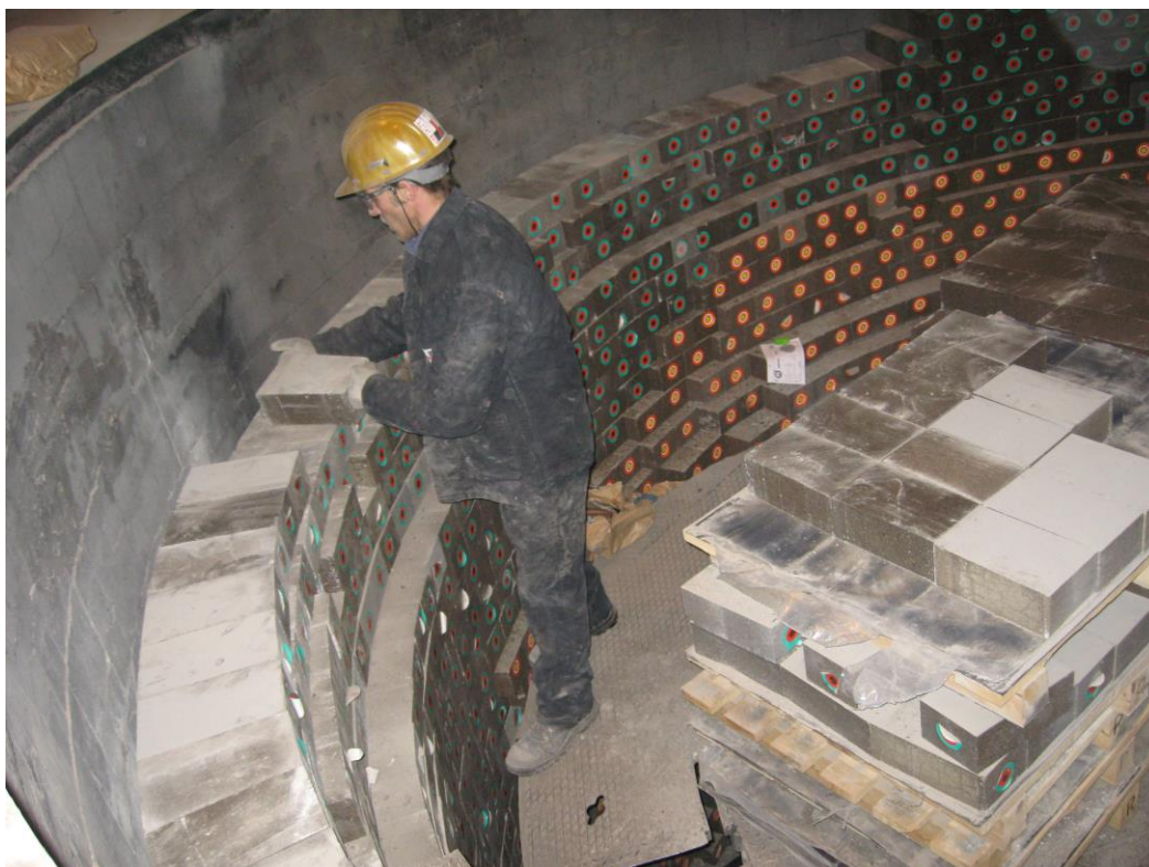
Fig. 1. Placement des briques réfractaires dans une poche à acier.
