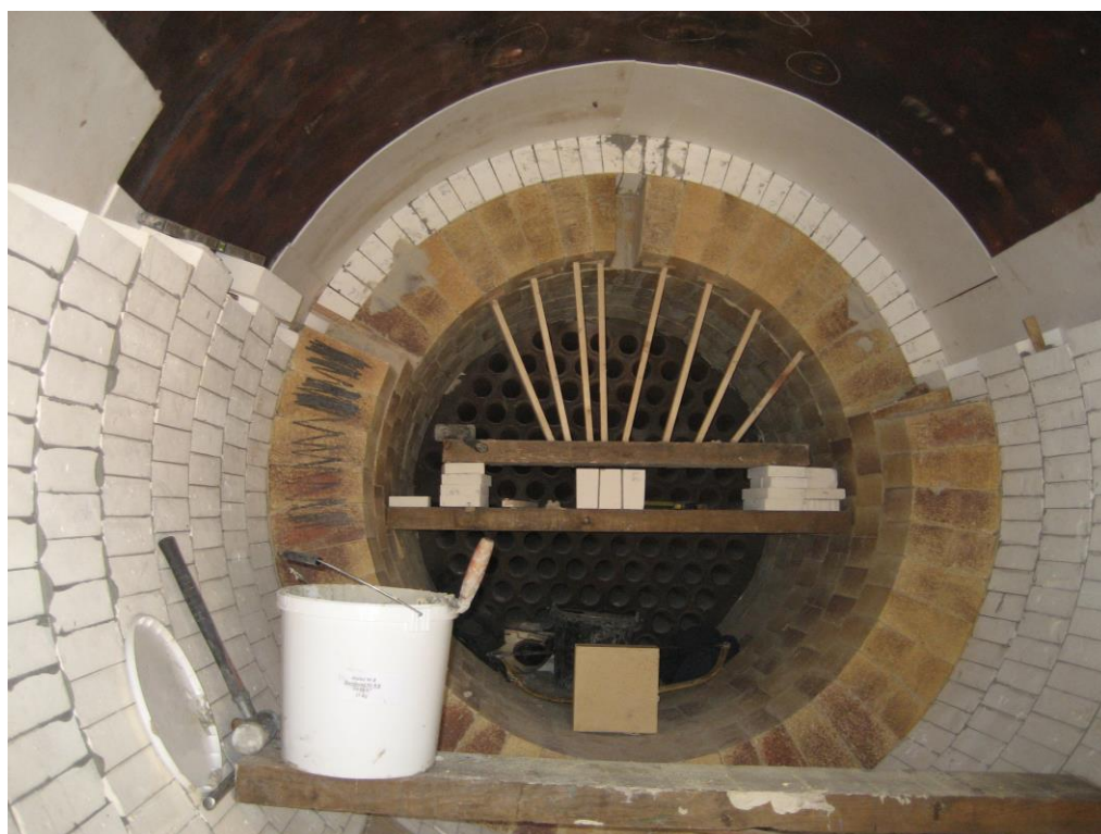
Fig. 34. Revêtement anti-usure dans un concasseur.
