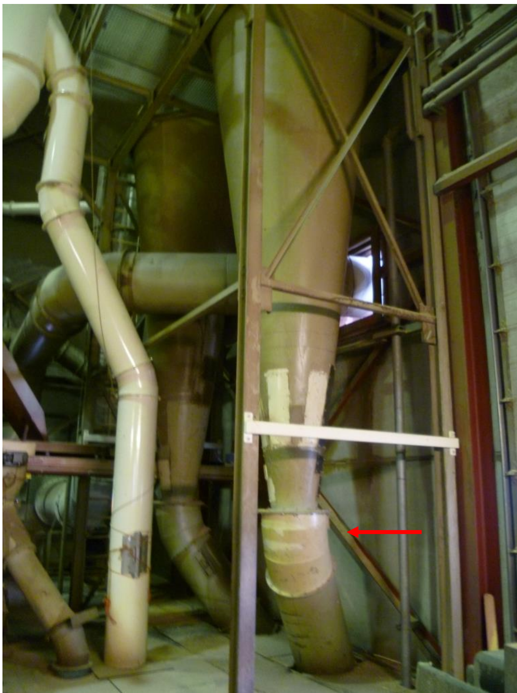
Fig. 40. Conduit laissant juste assez de place pour le travailleur chargé de la réfection anti-usure.
