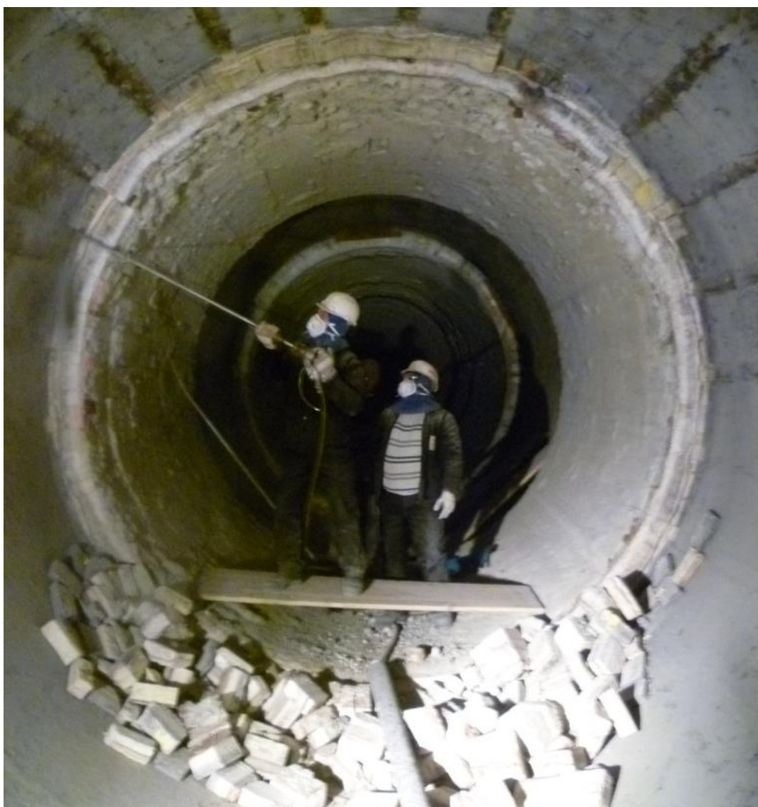
Fig. 3. Démolition à l'aide d'un marteau-pic dans un four de cimenterie.
