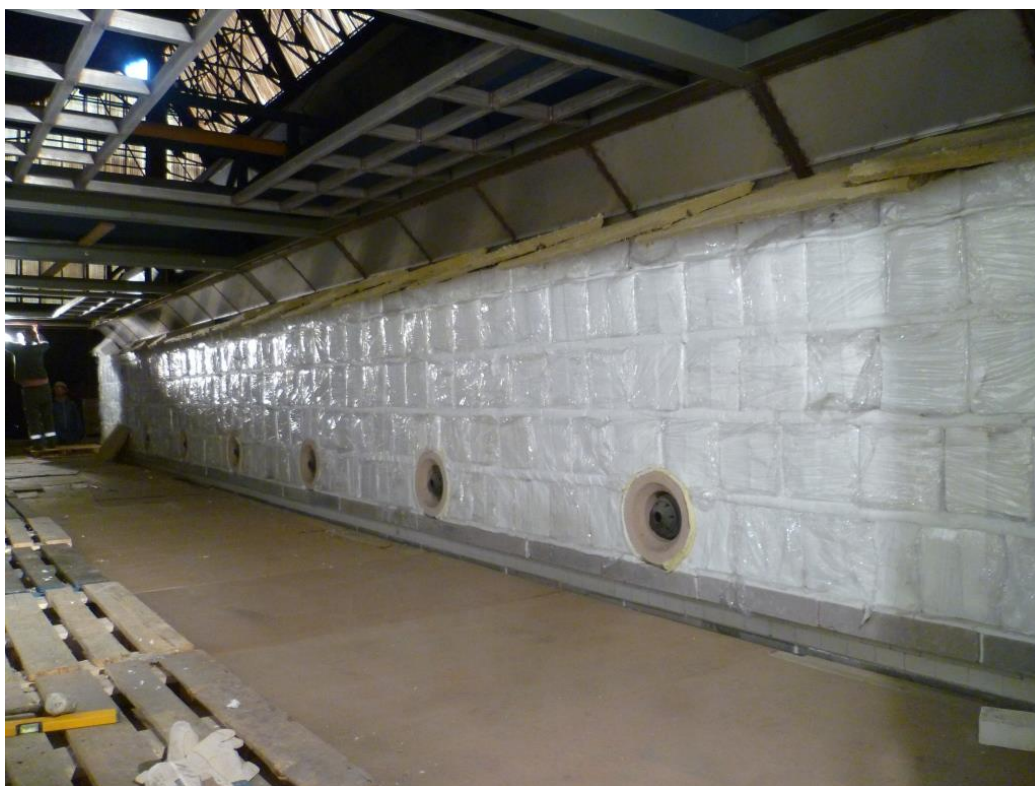
Fig. 28. Four après revêtement.
