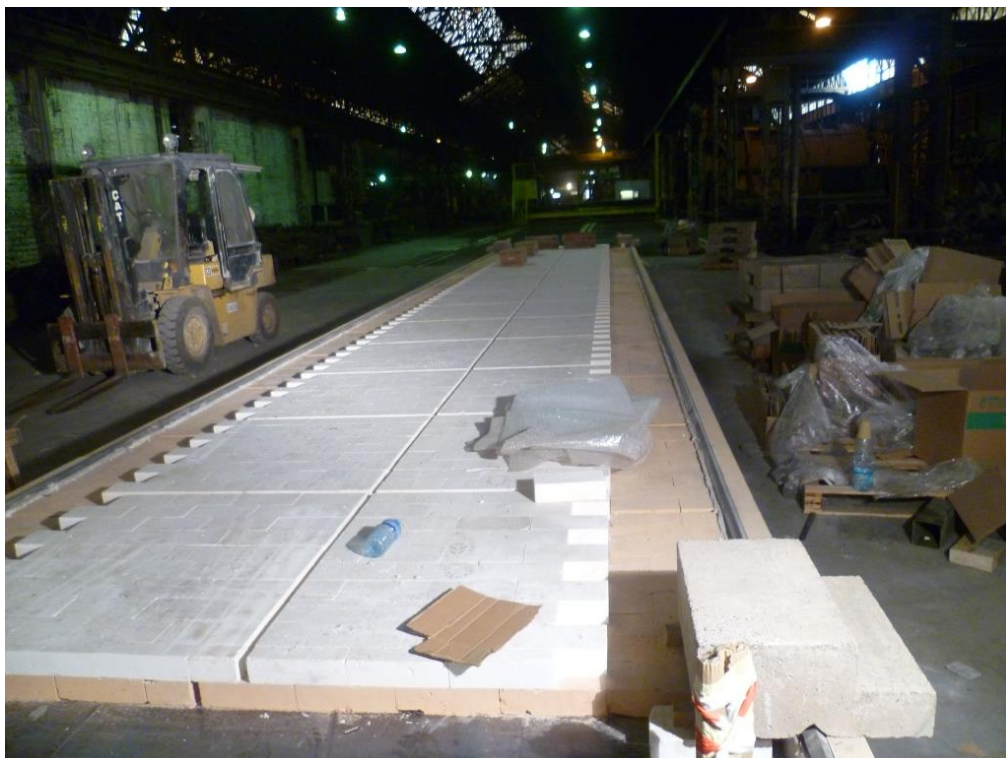
Fig. 29. Briquetage de la table du four.
