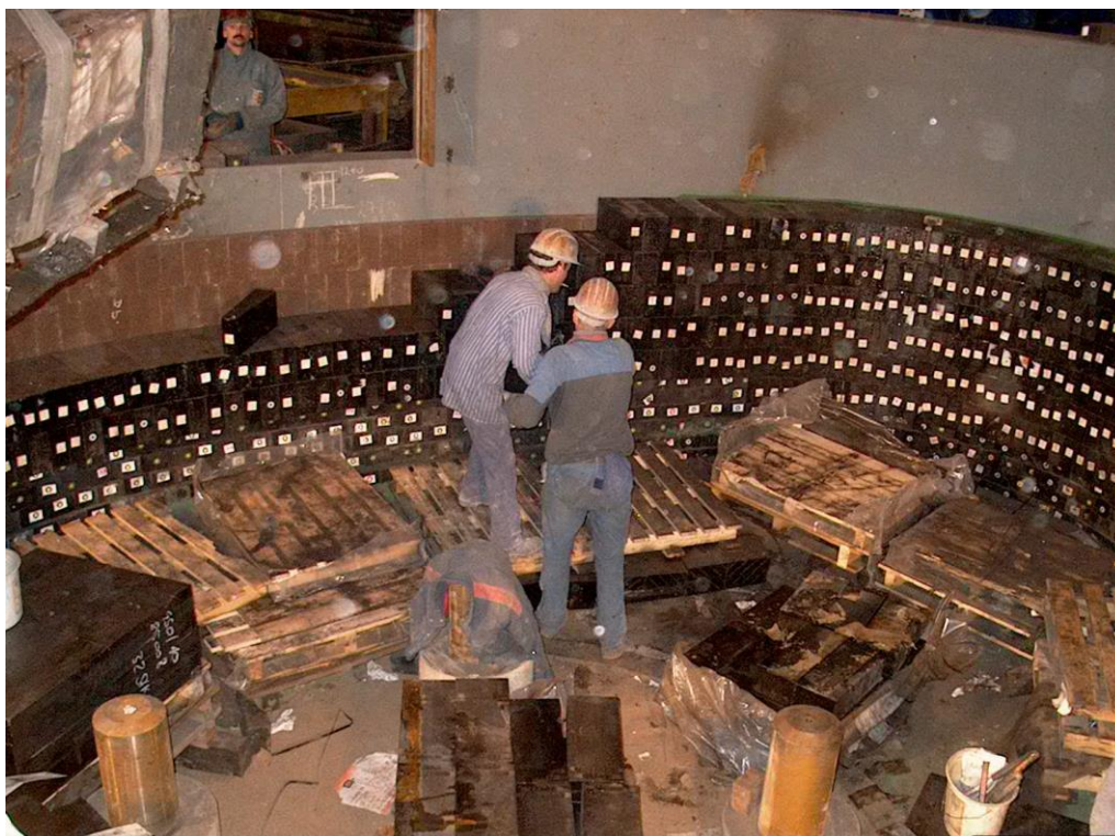
Fig. 6. Les palettes en bois sont laissées en place à la fin du chantier (four électrique).
