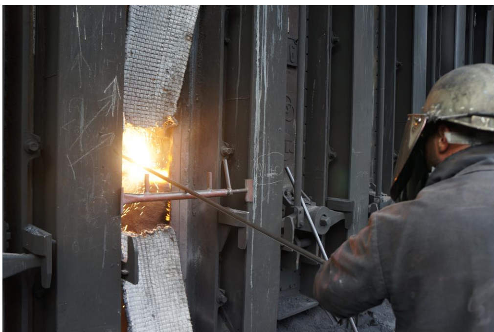
Fig. 14. Soudure céramique lors de la réfection d'un four.
