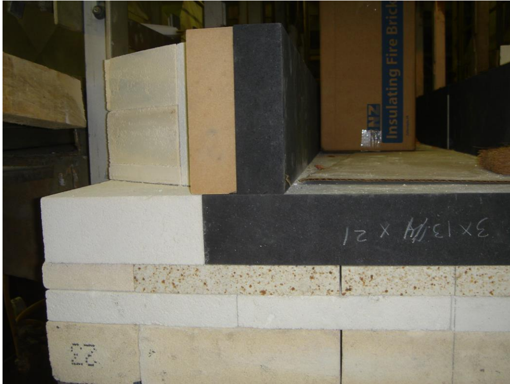
Fig. 22. Canal de coulée de verre en fusion. De l'intérieur vers l'extérieur : briques à base de chrome (gris foncé), briques à base de zircon (beige), briques de FCR (blanc).
