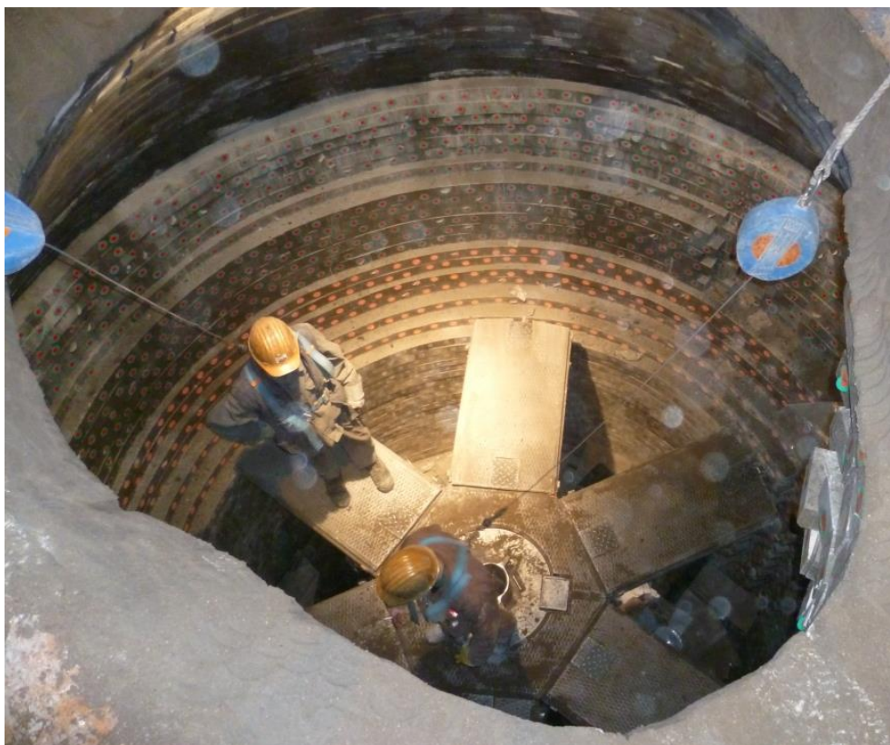
Fig. 4. Echafaudage en parapluie pour le travail en poche avec harnais de sécurité.
