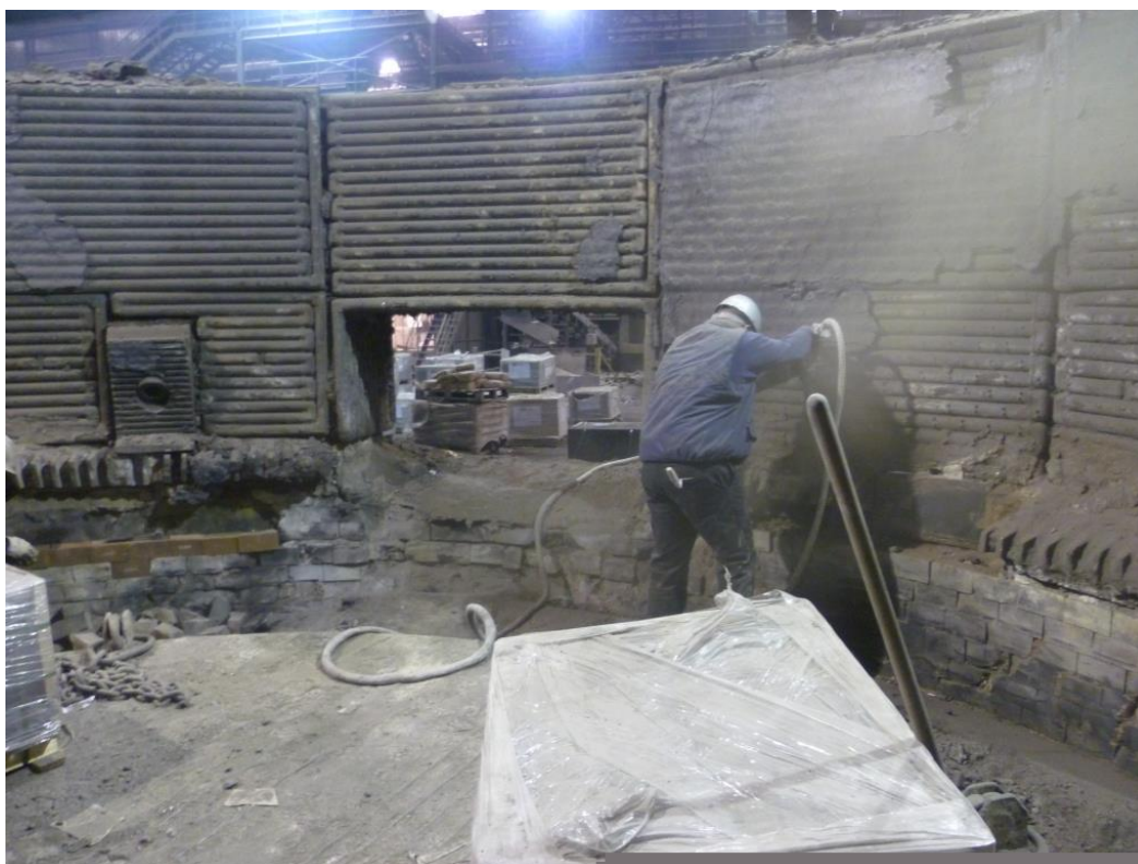
Fig. 2. Grapinage d'une zone de travail dans un four électrique.
