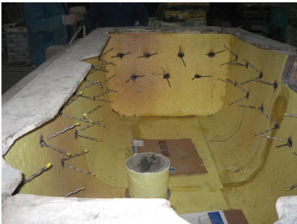
Fig. 25. Répartiteur armé avant coulée, tapissé d'une couche de protection.
