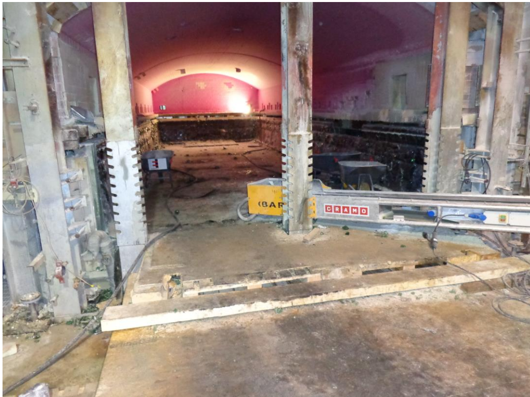
Fig. 20. Evacuation des déchets par bande transporteuse.
