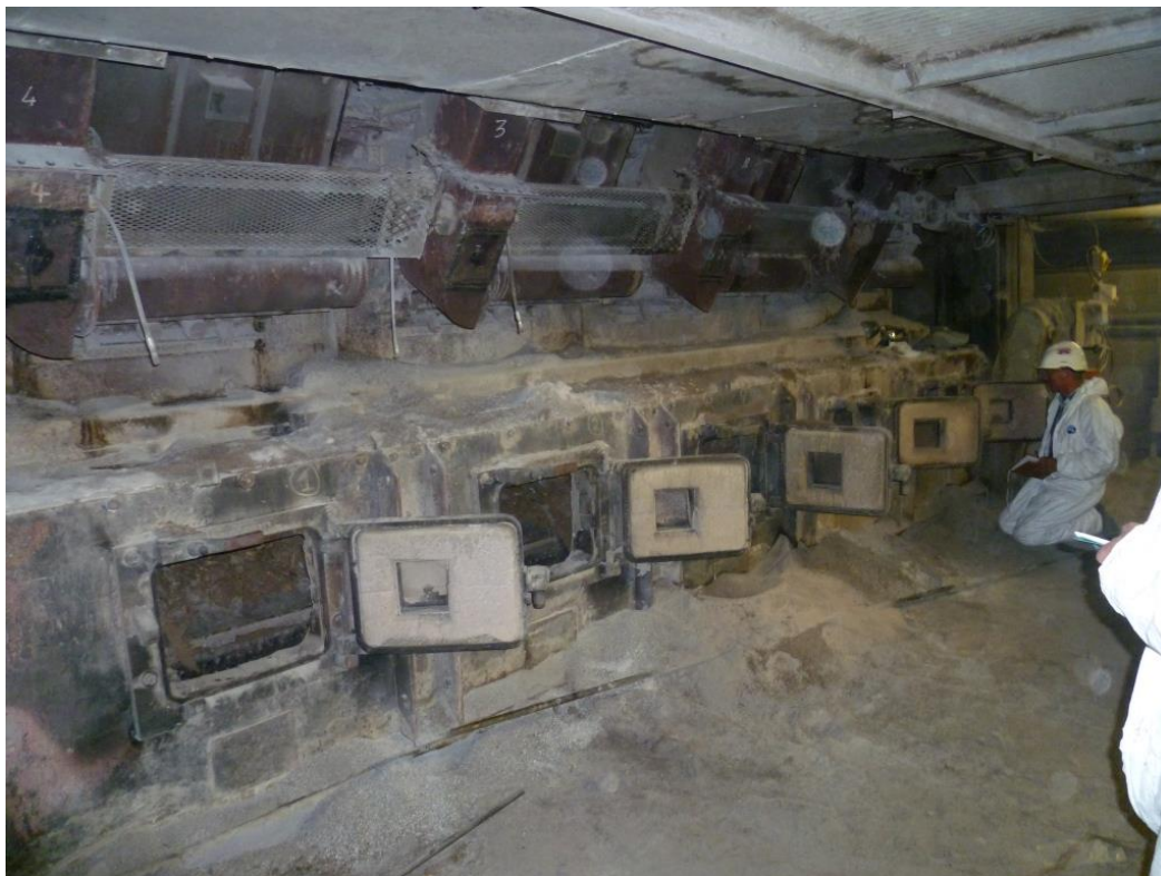
Fig. 33. Accès à des fours.
